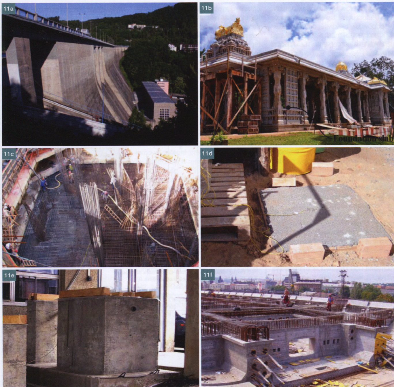
Obr. 11 Validované konstrukce pro maximální teploty, a) přehrada Orlík, b) půlka základové desky 36 x 17 x 0,65 m chrámu na ostrově Kauai, Hawaii (foto Himalayan Academy), c) základový blok 1050 m 3 v Balneário Camboriú, SC, Brazílie (foto Formula F10 Empreendimentos), d,e) dva bloky 1 m 3 , f) spodní deska mostovky Nového spojení v Praze (foto D. Prause) ■ Fig. 11 Validated constructions for maximum temperatures
